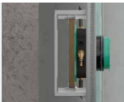
Instalacija na sistem nosača
