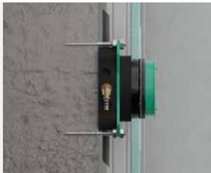
Instalacija na zid
